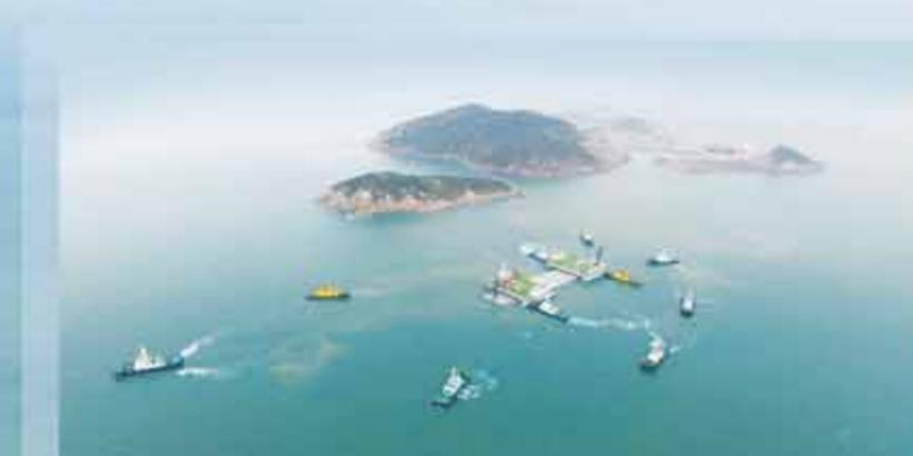
2017年3月7日，海底隧道最后一节沉管——E30管节安装取得圆满成功。
